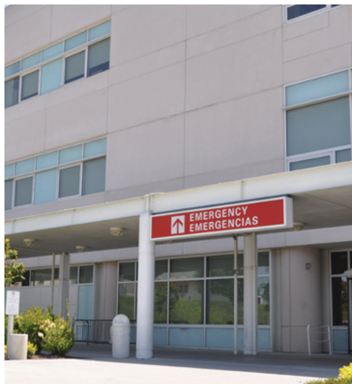
The ER entrance at Natividad in Salinas.
